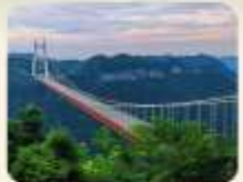
สะพานอ้ายจ้าย
