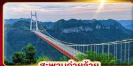
สะพานอ้ายจ้าย
