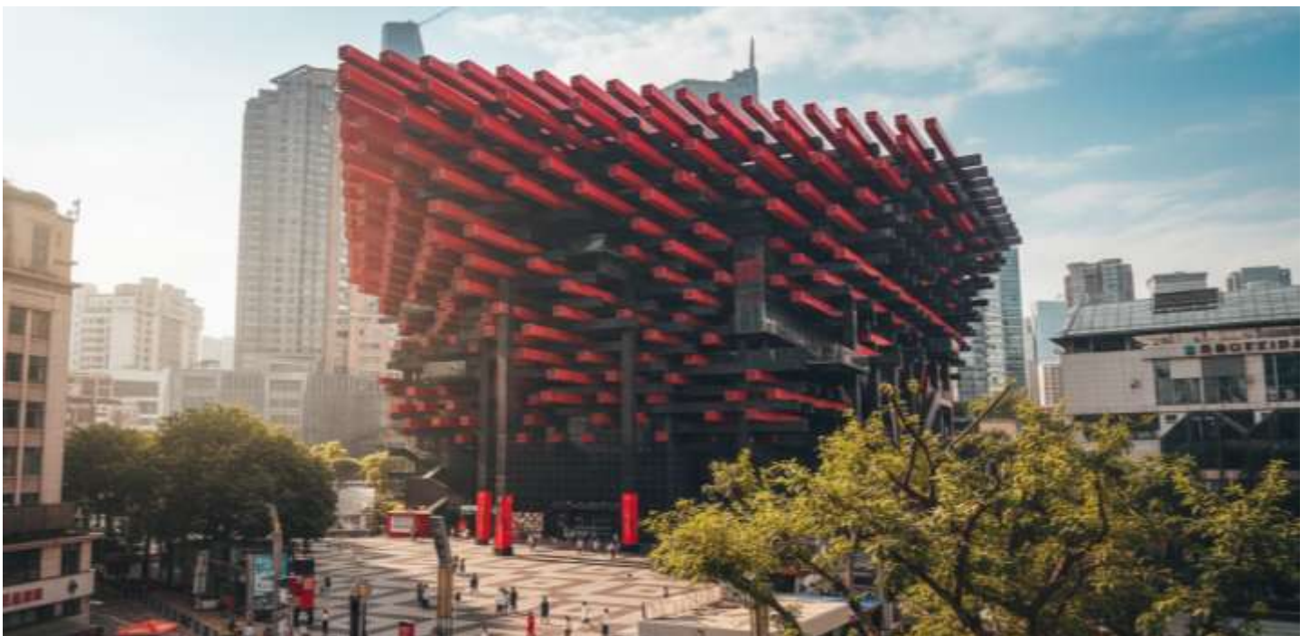
บ่าย นำท่านเช็ควิน ณ หอศิลป์แห่งฉงชิ่ง สถานที่ซึ่งตัวอาคารนั้นก็คืองานศิลปะชิ้นเอกชิ้นแรกที่ท่านจะได้พบ อาคารอันโดดเด่นด้วยรูปลักษณะของกล่องไม้ขีดไฟของยักษ์ หรือมัดตะเกียบ
