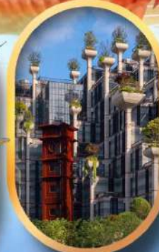
อาคารพินตันโม
