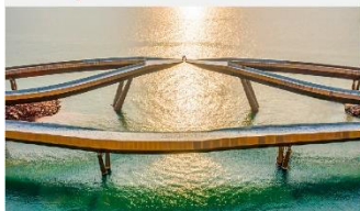
สะพานจูบ
